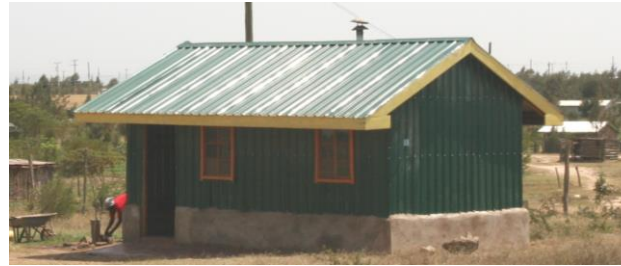
Das neue Schulküchenhaus in Baraka/Solio
